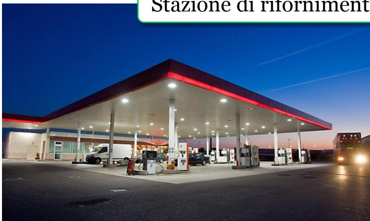
Stazione di rifornimento di benzina
